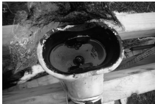
(図 3 雷放電後の放電装置)
